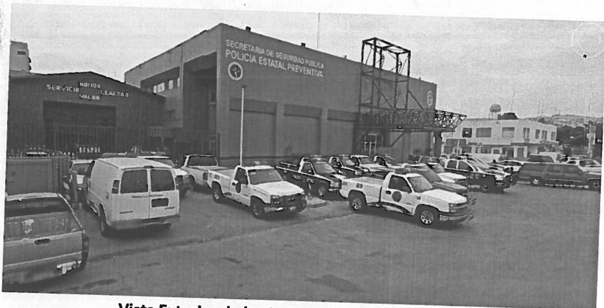
Vista Exterior de las Instalaciones de la PEP en Tijuana
